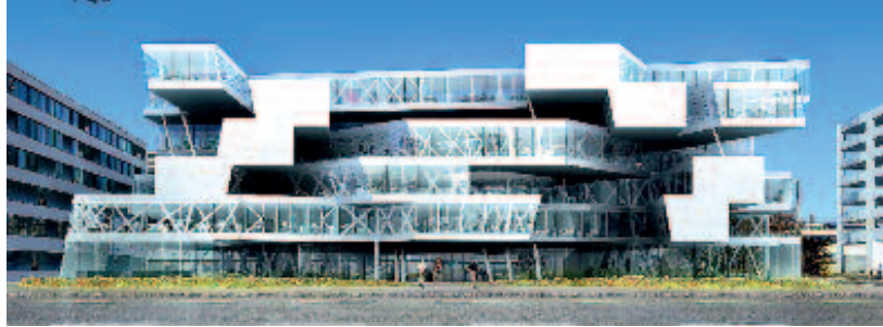
Im Bau: Actelion Business Center, Allschwil (Schweiz)
